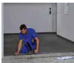
Opmeting ter plaatse
