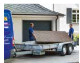
Demontage en milieuvriendelijke verwijdering
